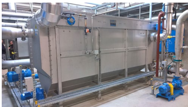
Slika 3: Izmenjevalnik toplote za odpadne vode HUBER RoWin
